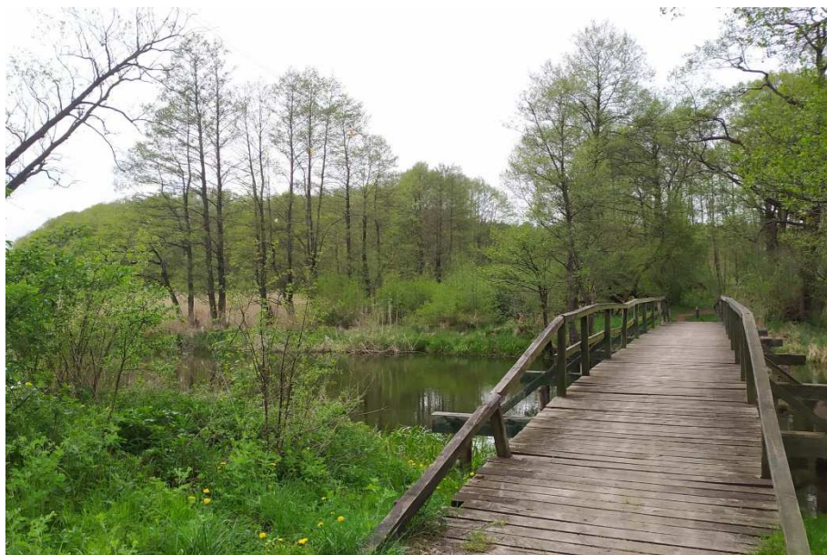
Fot. 3. Widok z lewego brzegu Drawy na płat 2_91E0 (lewa strona zdjęcia) oraz przecinkę pod istniejącą linią napowietrzną
