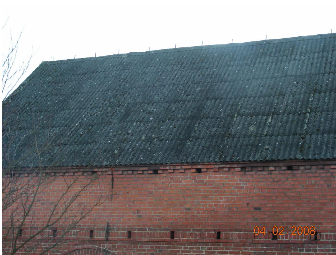
Pokrycie azbestowe budynku gospodarczego w Żółwinie (fot. 6)
