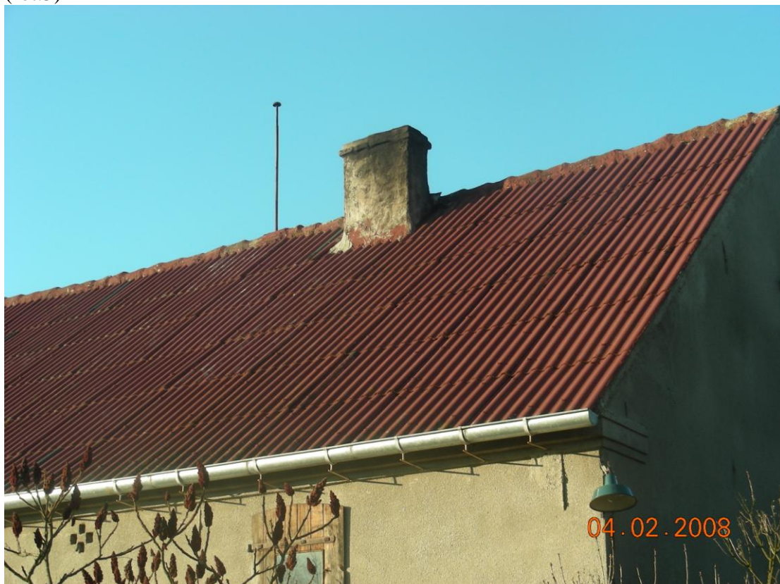
Pokrycie azbestowe - pomalowane (zabezpieczone) budynku mieszkalnego w Żółwinie (fot.5)
