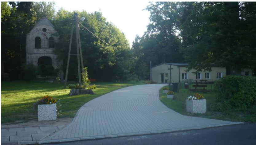
Świetlica wiejska w Chomętowie wraz z dojazdem
